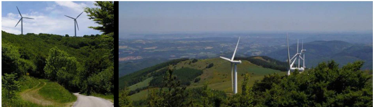
Vue en contre-plongée et vue en plongée du parc éolien de Merdelou (photo : F. Bonenfant)
